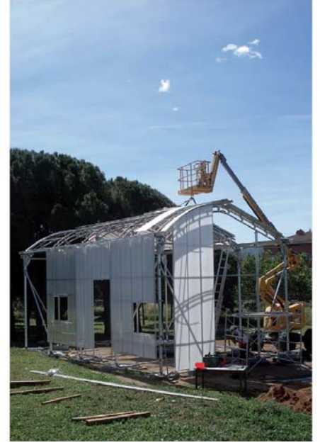
Estructura del invernadero en fase de montaje
