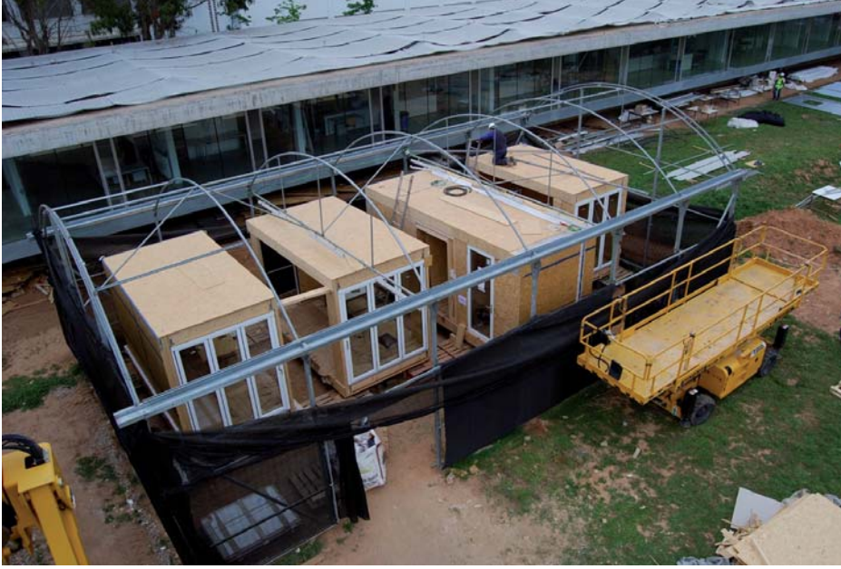
Módulos de madera en el hangar de montaje del Campus ETSAV
