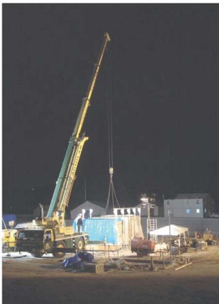
Elevación y colocación de los módulos habitacionales
