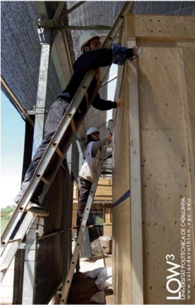
Construcción de los módulos de madera
