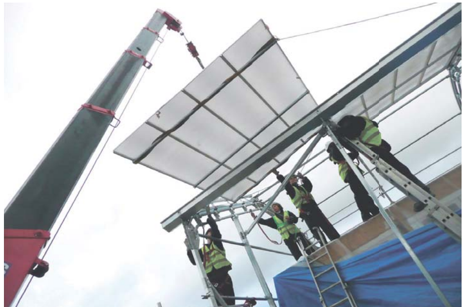
Colocación de un panel de la cubierta inclinada de policarbonato
