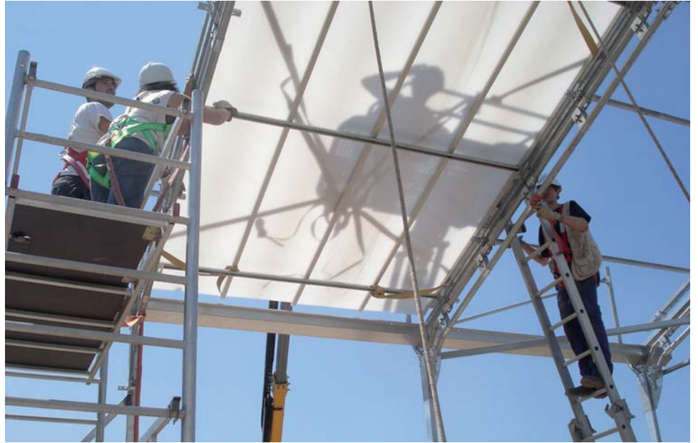
Prueba de colocación de un panel de la cubierta inclinada de policarbonato
