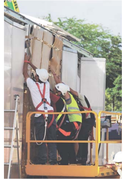
Colocación del colector ACS
