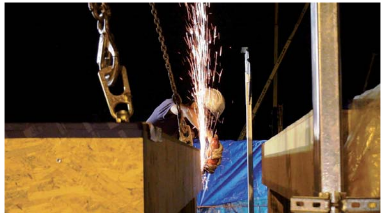
Ensamblaje de los módulos de madera
